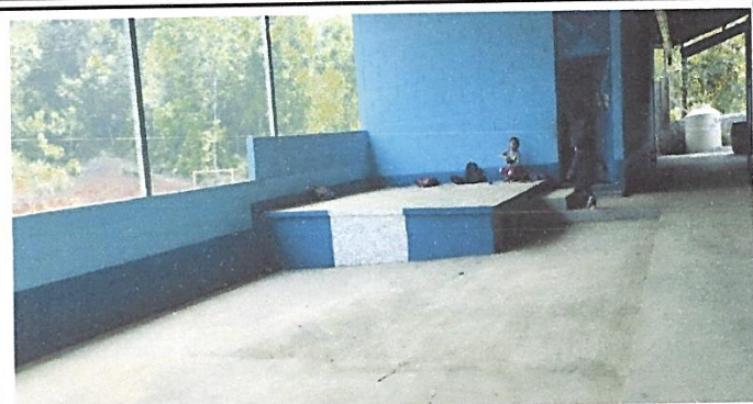
Foto 7: Reparación de escenario y entortado de área de comedor.
